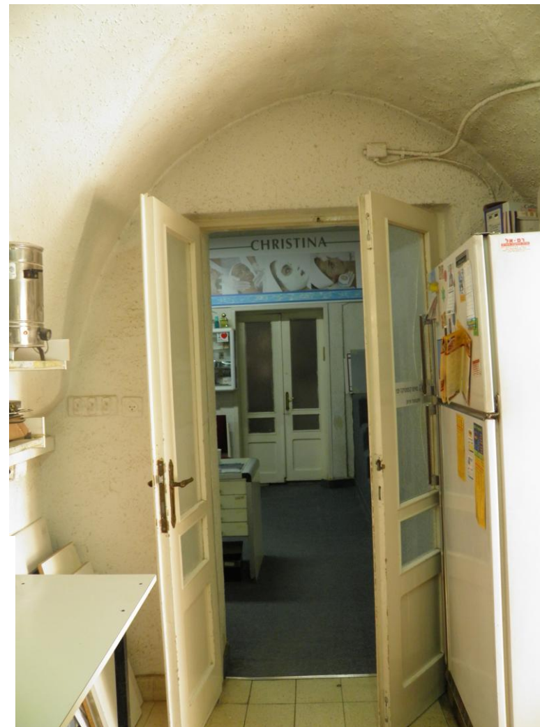
צילום דלתות כניסה לחדרים נוספים מחדר הלואיאן בקומה הראשונה. אפשר לראות בירור את הקשתות התומכות בתקרה וכי קירות המבנה רחבים במיוחד.
