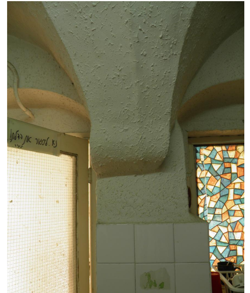
מפגש בין קמרון לקיר. קשת שתומכת בגג אחד החדרים היוצאים מחדר הלואיאן, שהוא החדר המרכזי הגדול בקומה א'.
